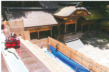
諏訪大社の修理 ▶
